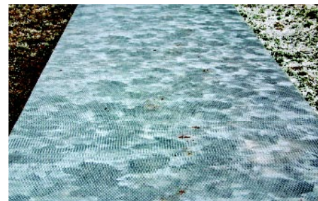
海に近い敷地ということから、グラフィックコンクリートも波や砂浜のパターンを用いた
